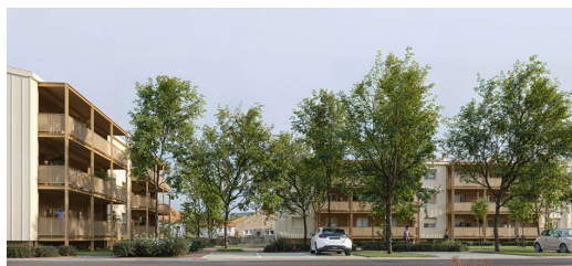
Vue d'ensemble bâtiment A et B
