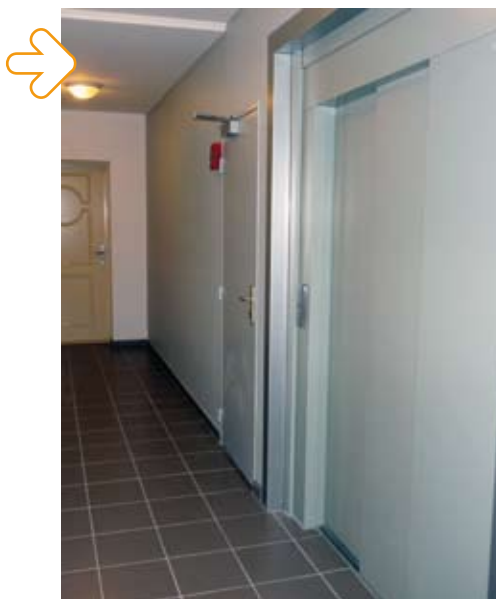
La résidence est dotée d'un ascenseur
