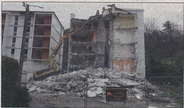
La pelle hydraulique munie d'une pince est venue grignoter les bâtiments.
