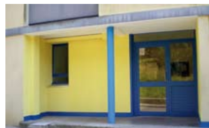
Bâtiment "Soleil Levant" à Nogent après les travaux
