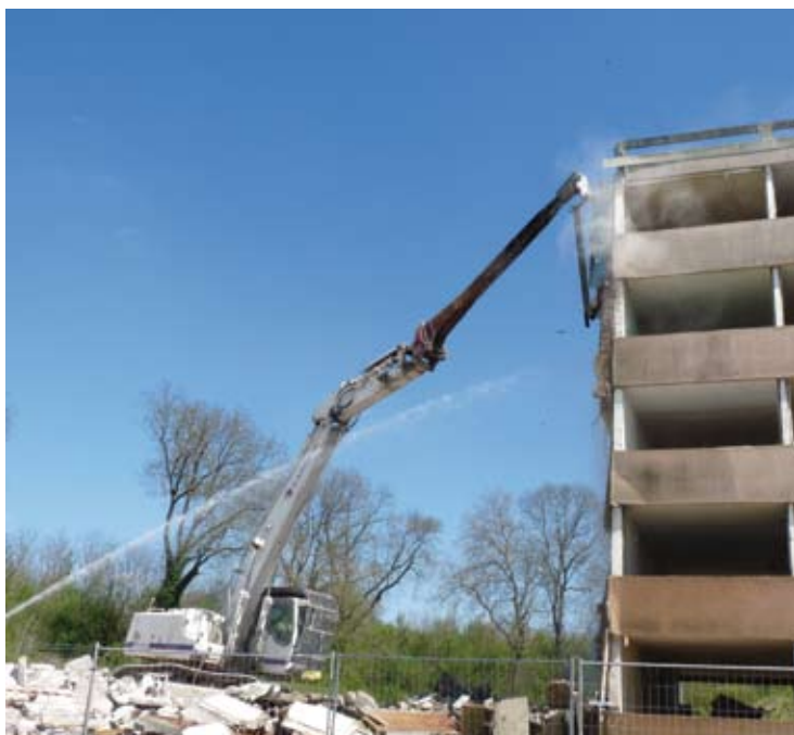
Désamiantage et démolition du bâtiment "Les Dahlias" à Langres
