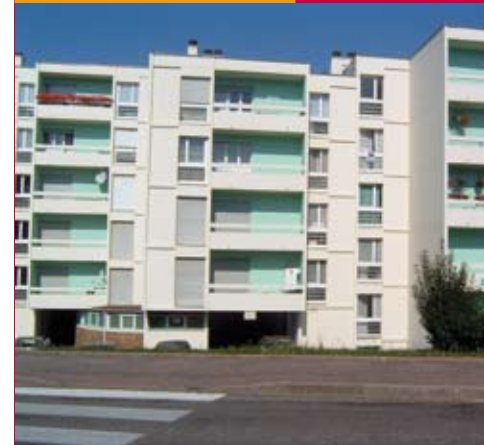
Langres bâtiment «Zinnias»
